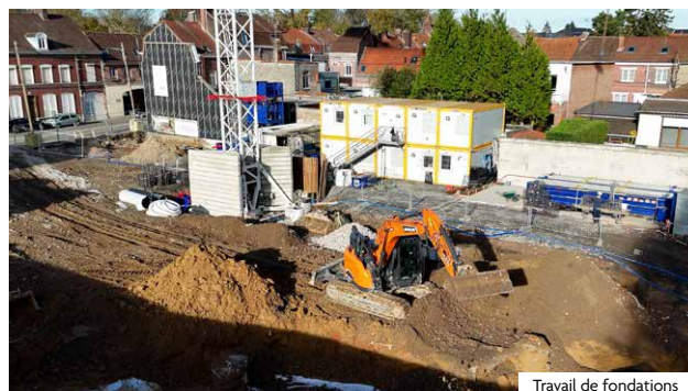
Travail de fondations
