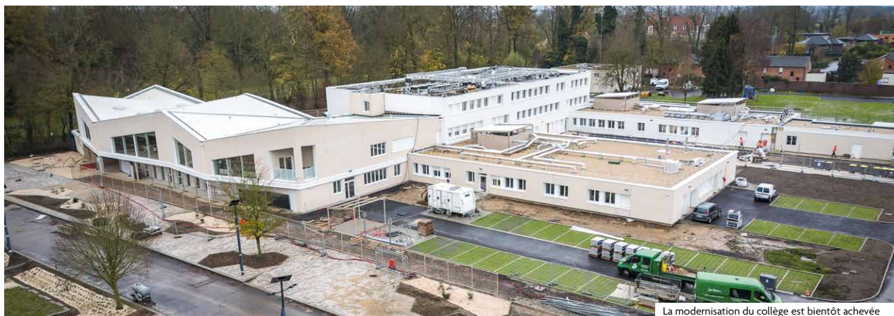
La modernisation du collège est bientôt achevée
