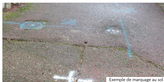
Exemple de marquage au sol
