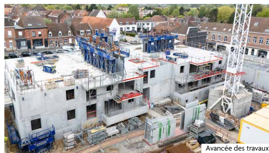
Avancée des travaux
