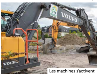
Les machines s'activent
