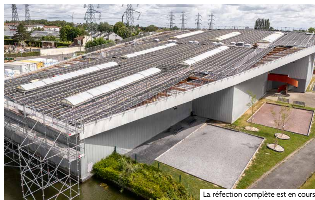
La réfection complète est en cours
