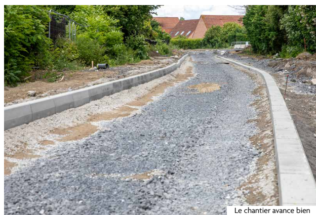
Le chantier avance bien
